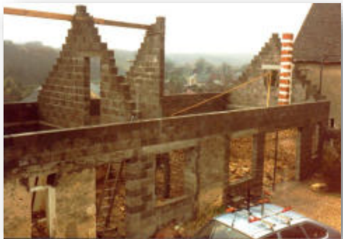
Les travaux du Pont en 1979/80
