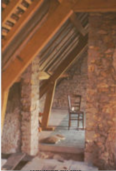
Isolation du toit
