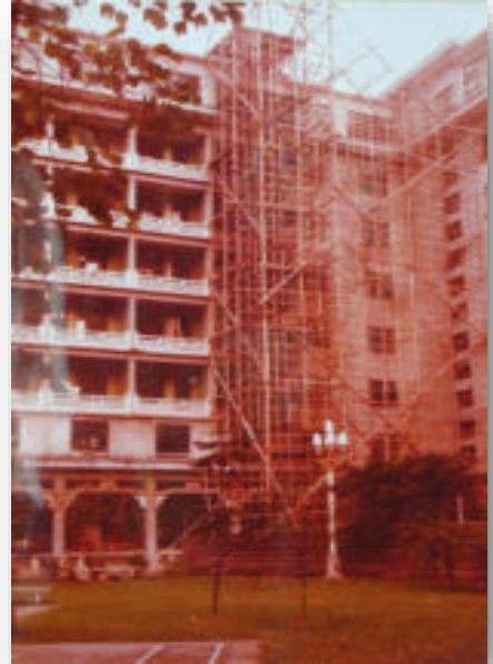
Échafaudage de bambous
