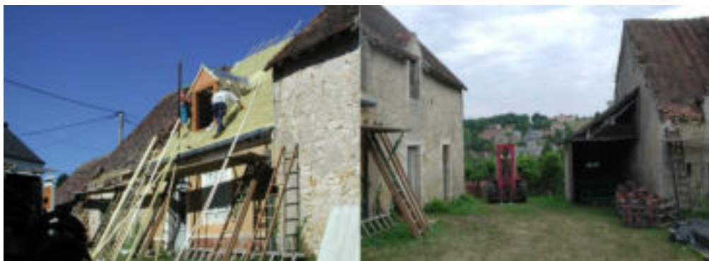
Les travaux rue de l'Époque
