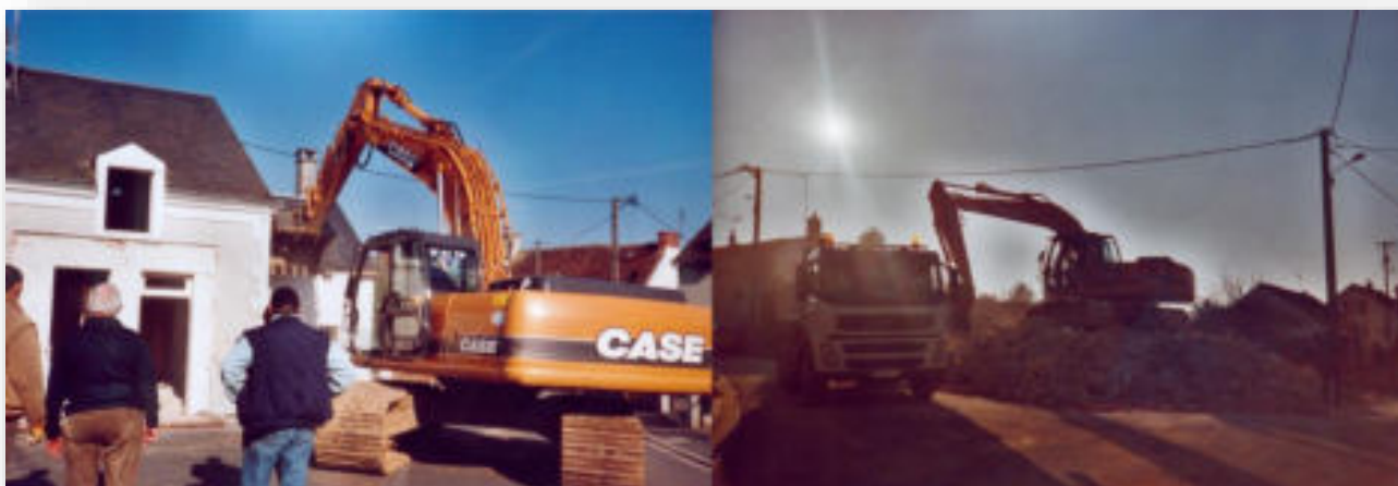
Démolition de la maison Talbot le ( février 2008)
